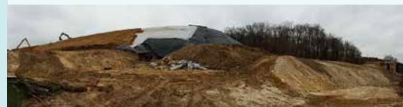
Reprise de la couverture du casier 2 à Réaup-Lisse
