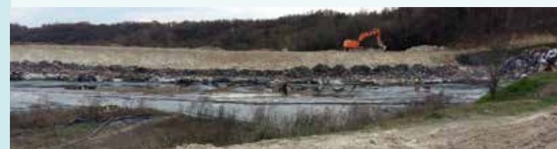
Digue à Nicole
